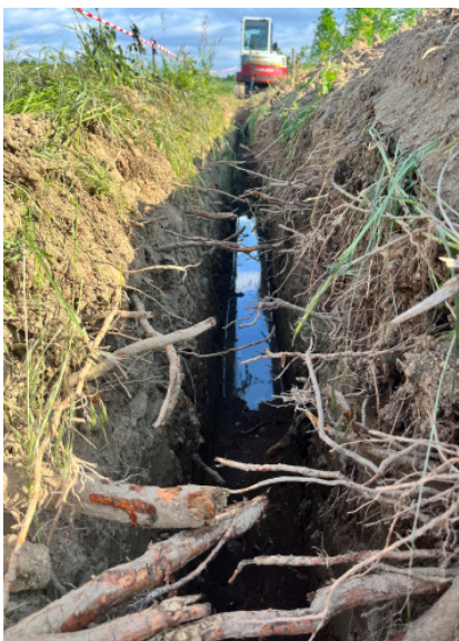
Fuite sur le secteur de La Belle Escale à Eteimbès. _ Recherche d'une fuite sur un linéaire de 1 700 mètres de canalisation non tracée.
