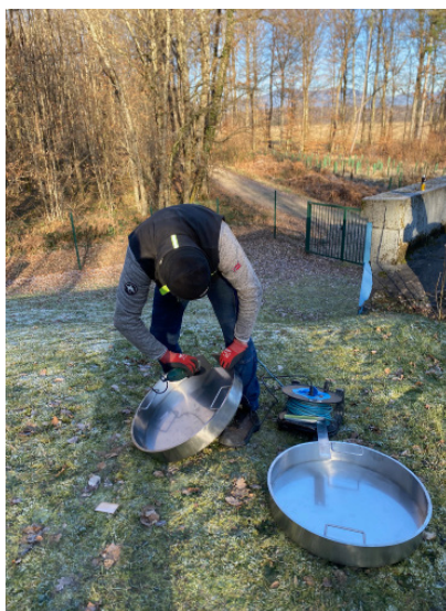
Pose de 9 cuves de rétention sur les sites des ouvrages sensibles, pour sécuriser les ouvrages contre les intrusions de nuisibles
