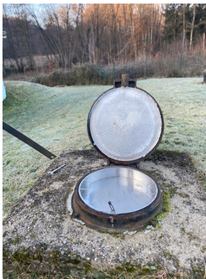
Pose de 9 cuves de rétention sur les sites des ouvrages sensibles, pour sécuriser les ouvrages contre les intrusions de nuisibles
