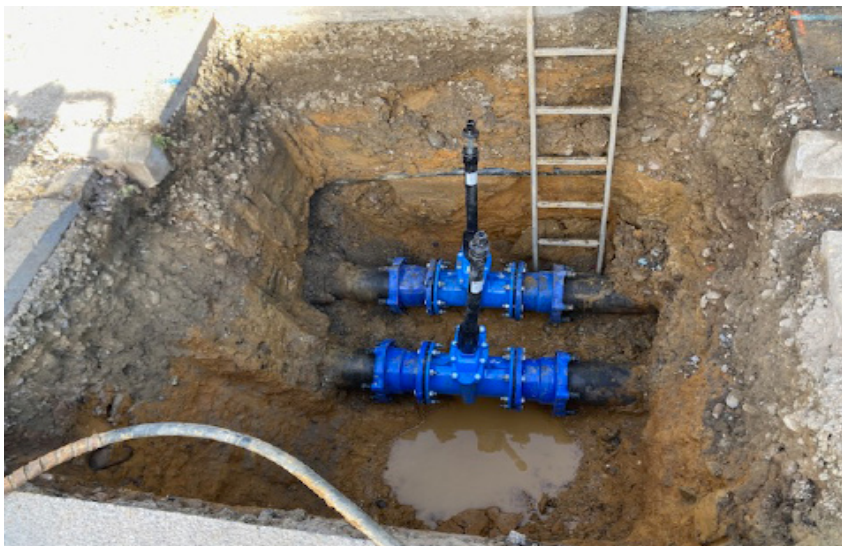
Poursuite de la campagne pluriannuelle des poses de vanne de sectionnement Ici à Eteimbès, rue du Haut Bois
