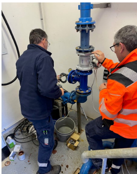
Changement de débitmètre au Forage A
