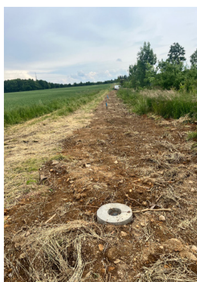
Fuite sur le secteur de La Belle Escale à Eteimbès. _ Recherche d'une fuite sur un linéaire de 1 700 mètres de canalisation non tracée.
