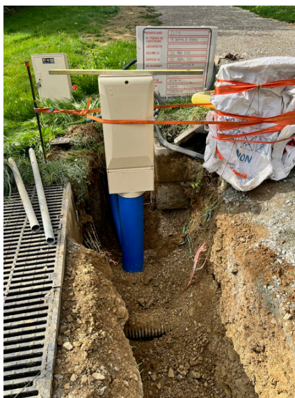
Mise en place de bornes de comptage pour les nouveaux branchements
