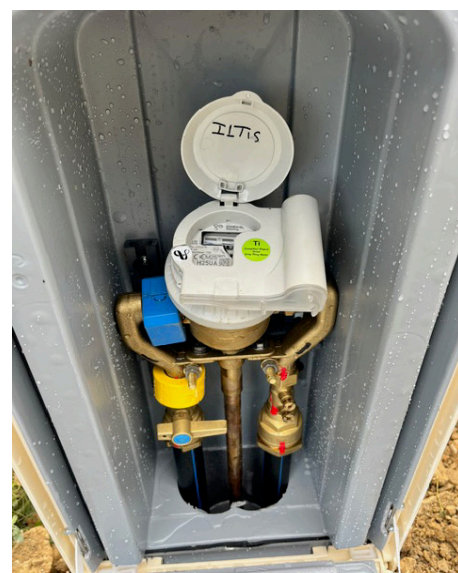
Mise en place de bornes de comptage pour les nouveaux branchements
