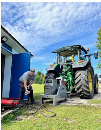
Installation d'une génératrice de force motrice, destinée à assurer une alimentation électrique de secours afin de maintenir la continuité du service en cas de coupure d'électricité.
