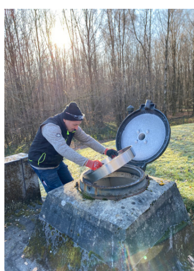
Pose de 9 cuves de rétention sur les sites des ouvrages sensibles, pour sécuriser les ouvrages contre les intrusions de nuisibles
